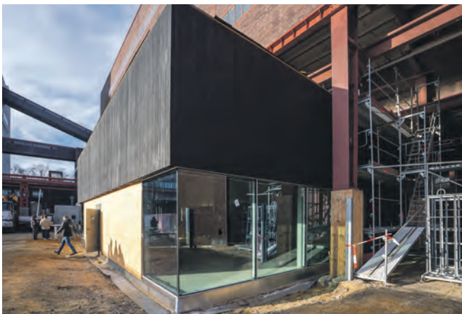
Die nächsten Bauabschnitte konzentrieren sich auf den Innenausbau.
